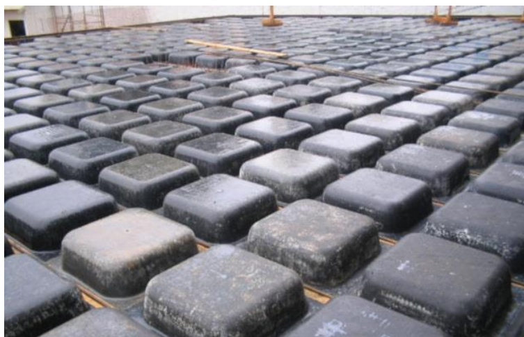
Figura 2 - Formas tipo cubetas plásticas para execução de lajes nervuradas
