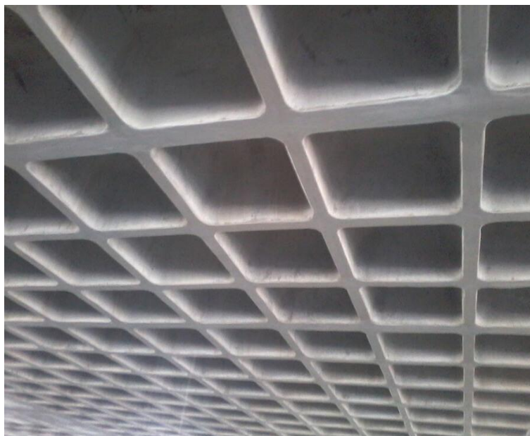
Figura 3 - Laje nervurada executada com cubas plásticas
