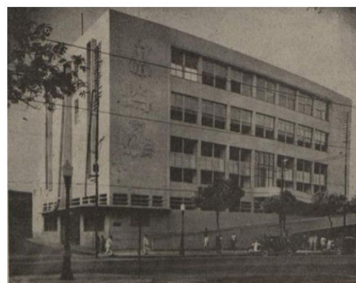
Figura 2-Fachada do prédio do SAPS em frente à Praça da Bandeira, no Rio de Janeiro
