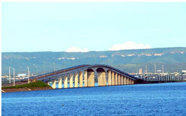
Figura 14 - Ponte Fernando Henrique Cardoso – Palmas, TO.
