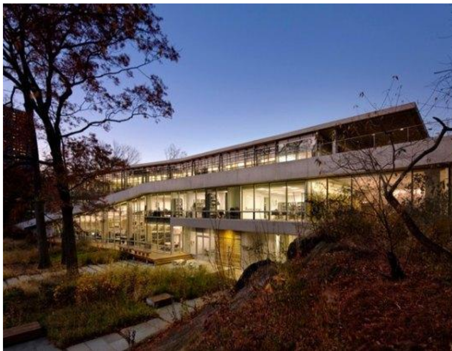
Figura 7 - Vista do Prédio do CGC
