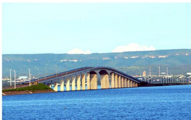
Figura 2 - Ponte Fernando Henrique Cardoso
