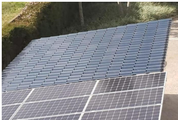
Figura 17 – Telha com estrutura fotovoltaica
