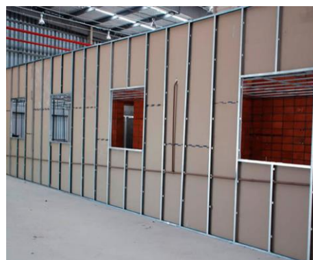
Figura 37 – construção do sistema Drywall
