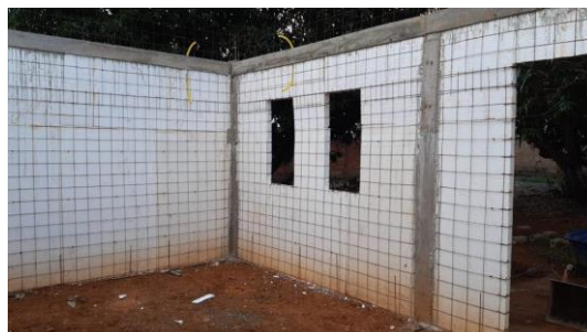
Figura 25 - Método De Construção Com Poliestireno Expandido
