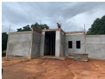
Figura 24 - Método De Construção Com Poliestireno Expandido
