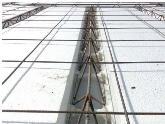
Figura 27 - Elementos de uma laje de isopor
