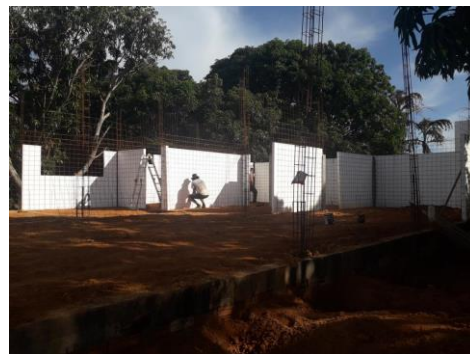
Figura 23 - Método De Construção Com Poliestireno Expandido
