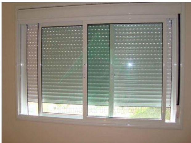
Figura 38 – Janelas com persianas manuais
