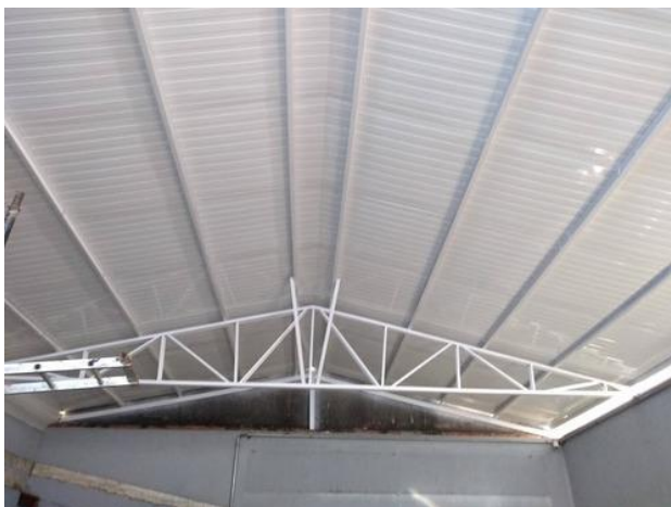
Figura 32 – Estrutura metálica para telha sanduíche
