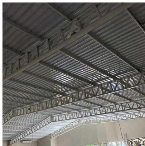
Figura 33 - Estrutura metálica para telha sanduíche
