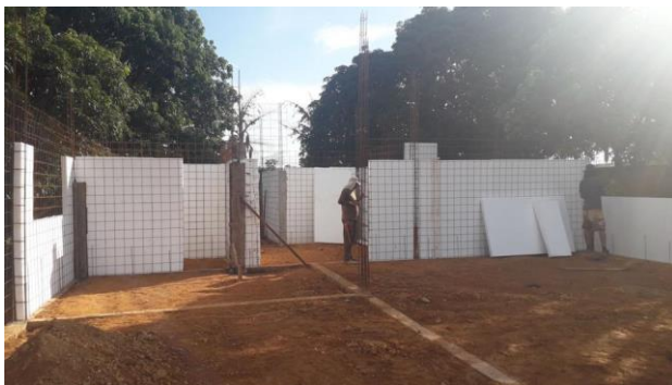
Figura 22 - Método De Construção Com Poliestireno Expandido
