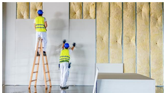
Figura 35 – construção do sistema Drywall
