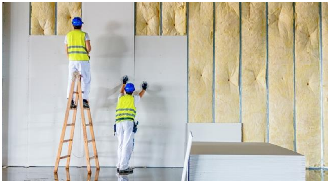
Figura 06 – construção do sistema Drywall
