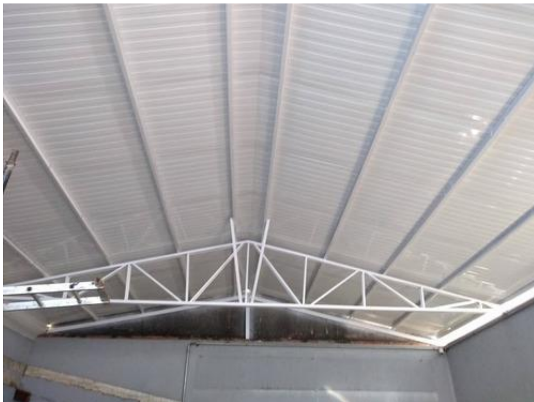
Figura 15 – Estrutura metálica para telha sanduíche
