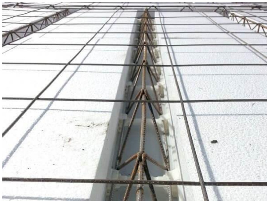
Figura 10 - Elementos de uma laje de isopor
