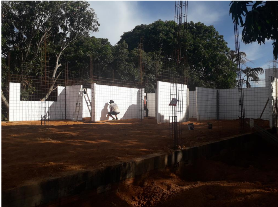
Figura 02 - Método De Construção Com Poliestireno Expandido
