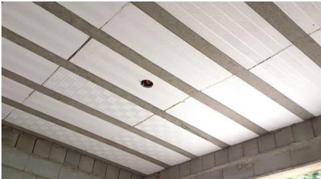
Figura 12 - Elementos de uma laje de isopor
