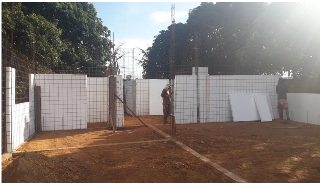
Figura 01 - Método De Construção Com Poliestireno Expandido
