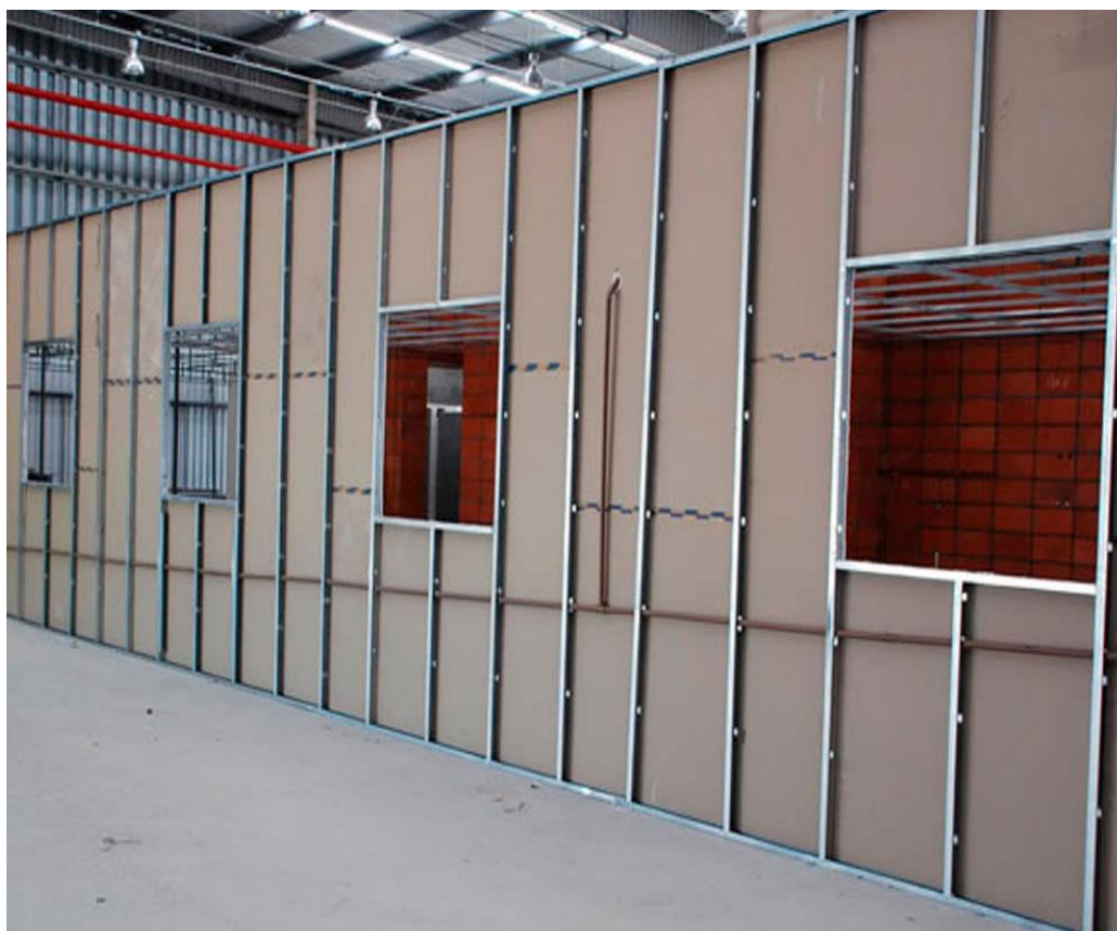
Figura 08 – construção do sistema Drywall
