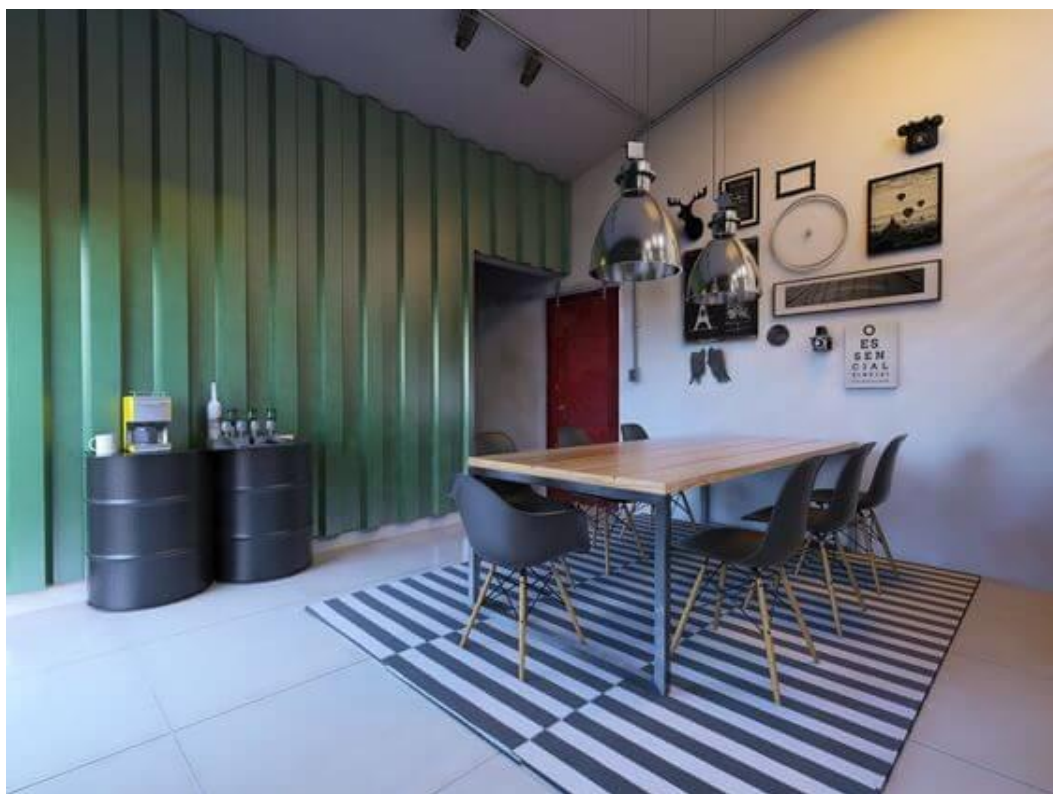
Figura 14 - Telha Sanduíche como divisória interna
