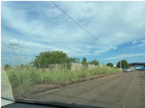
Figura 07 – Alameda 03B – Iluminação pública existente
