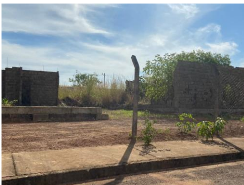
Figura 09 - Alameda 05B – Calçamento público existente
