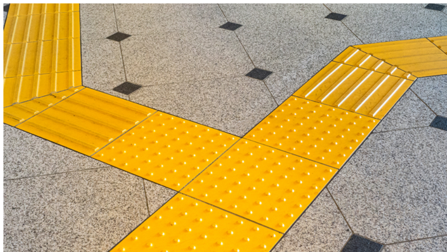
Figura 22 - Piso Tátil de Alerta e Direção
