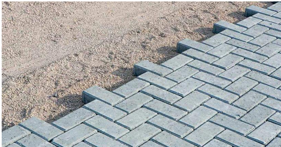
Figura 33 - Bloco Intertravado Espinha de Peixe
