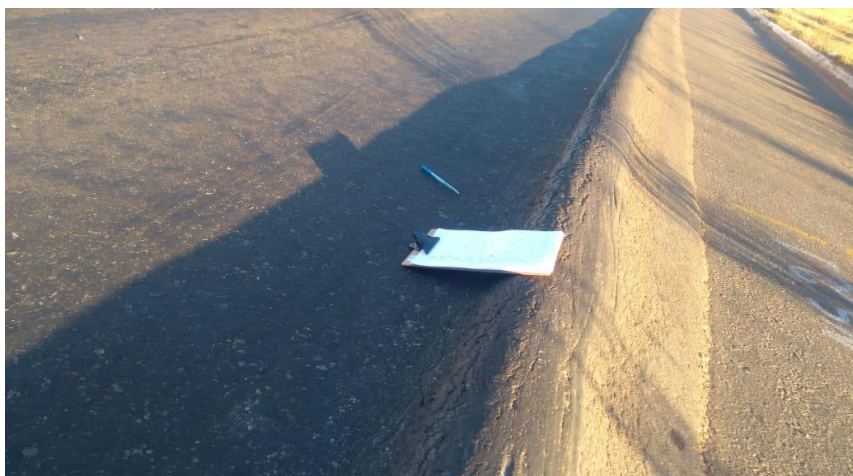
Figura 26: Afundamento Plástico Fonte: o autor (2021)
