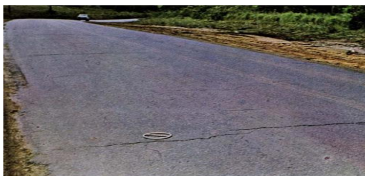
Figura 06 – Trinca transversal Fonte: Norma DNIT 005/2003 - TER
