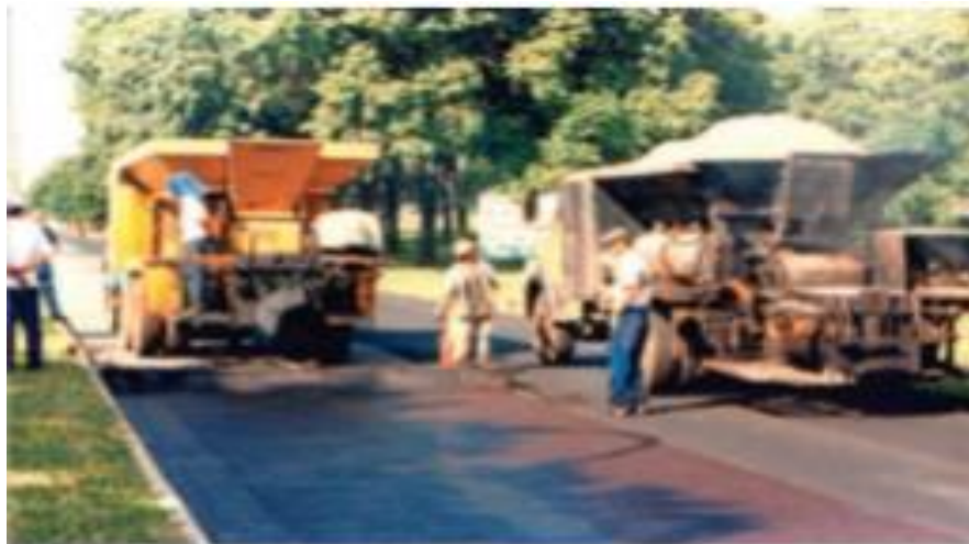
Figura 28: Aplicação de Lama Asfáltica Fonte: BERNUCCI 2008
