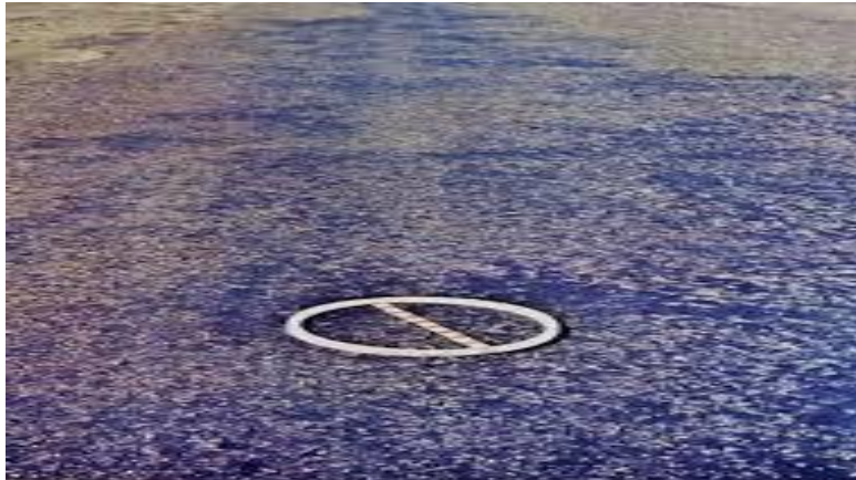
Figura 11 - Exsudação Fonte: Norma DNIT 005/2003 – TER
