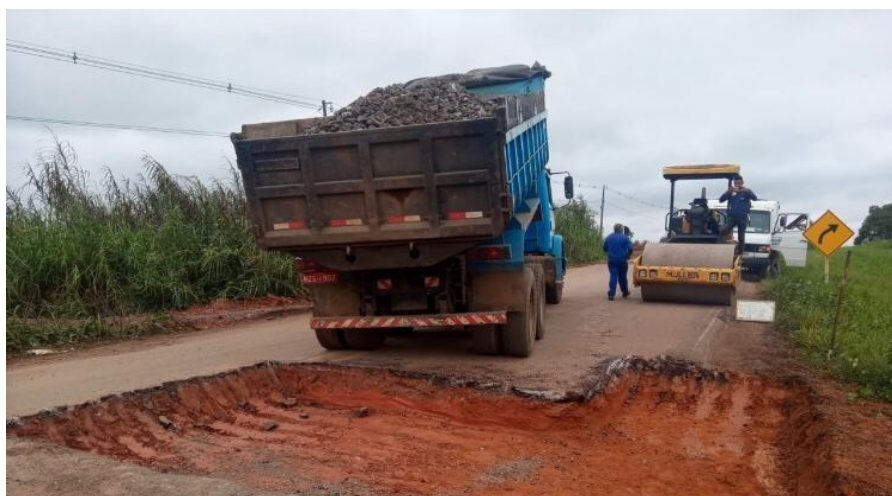
Figura 15 – Remendo profundo
