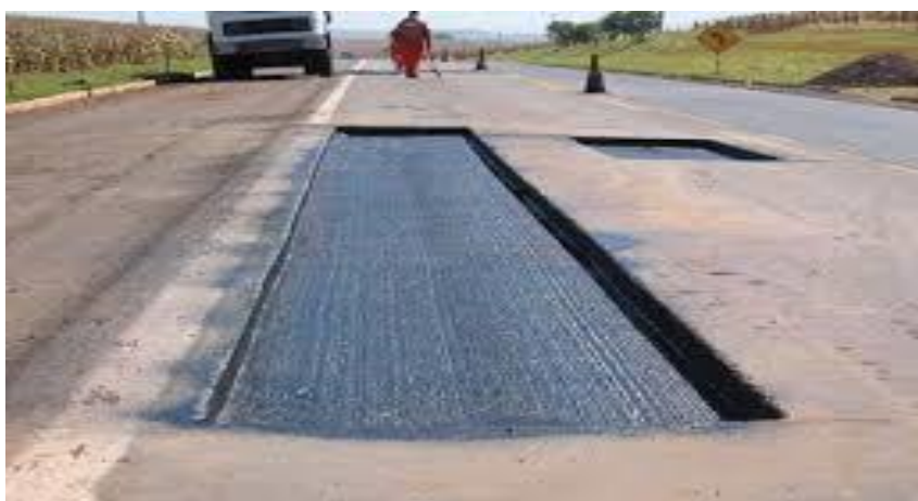
Figura 16 – Remendo superficial
