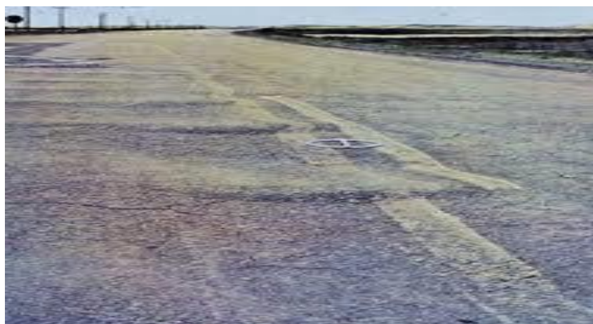
Figura 19 – Ondulação ou corrugações Fonte: Norma DNIT 005/2003 – TER
