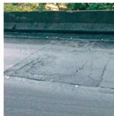
(d) Trinca de retração (TRR)
