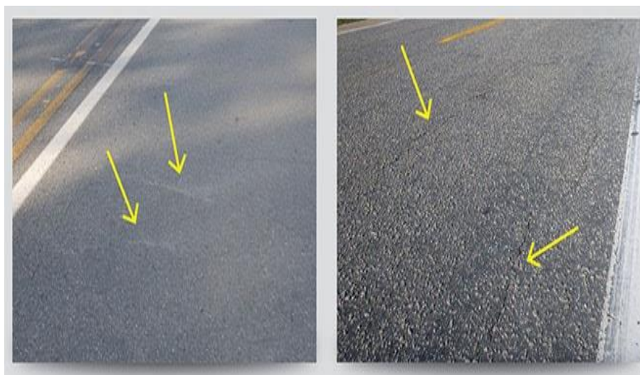
Figura 05 – Fissuras
