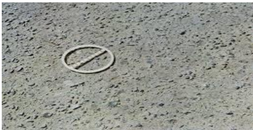
Figura 14 - Desgaste Fonte: Norma DNIT 005/2003 – TER
