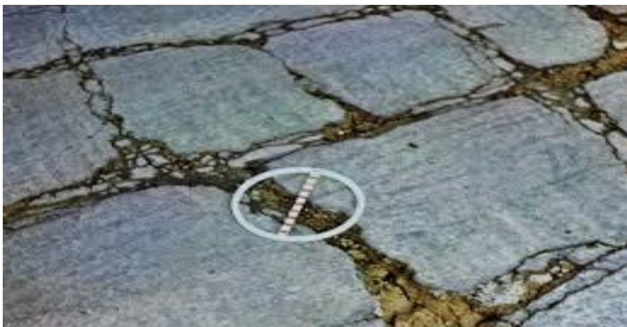
Figura 10 – Trinca tipo bloco Fonte: Norma DNIT 005/2003 – TER
