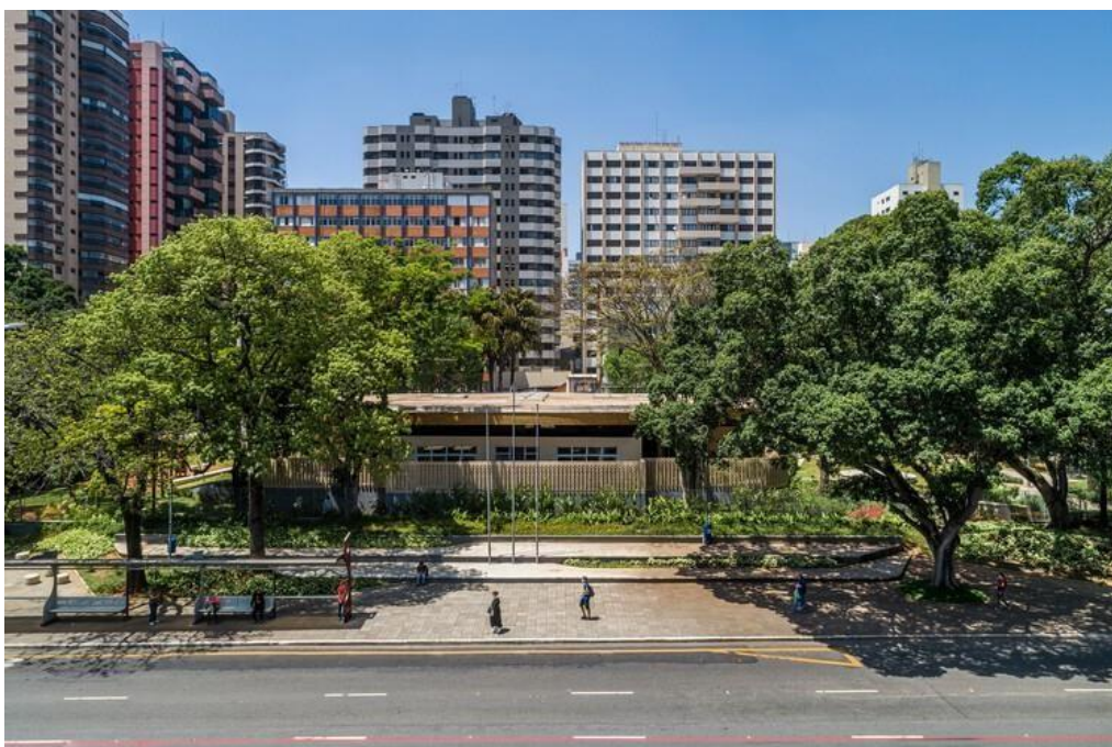
Figura 5- Vista frontal da escola no centro da praça.
