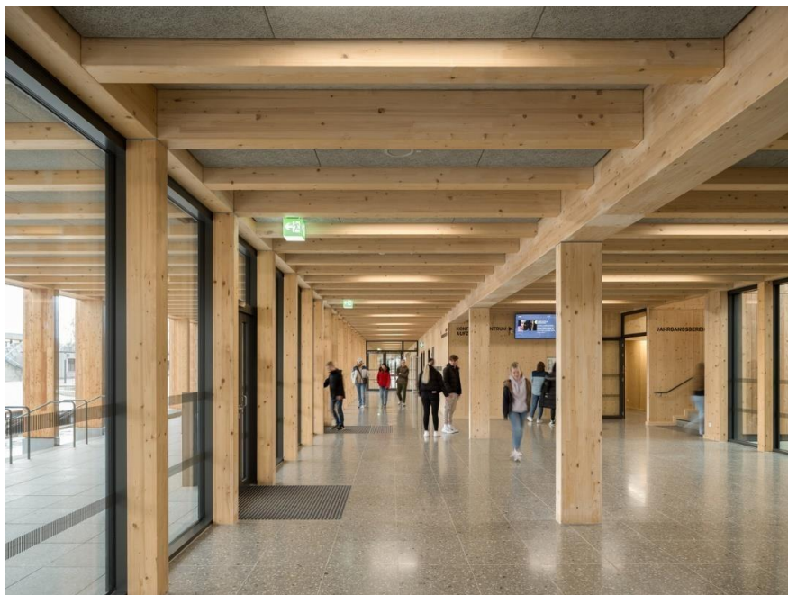
Figura 13. Uso de madeira na estrutura
