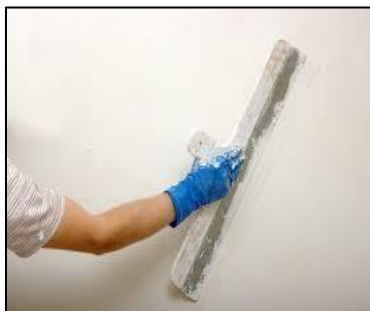
Figura 4 - Acabamento em gesso.
