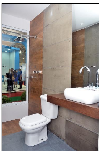
Figura 6 - Placas cimentícias área molhada.
