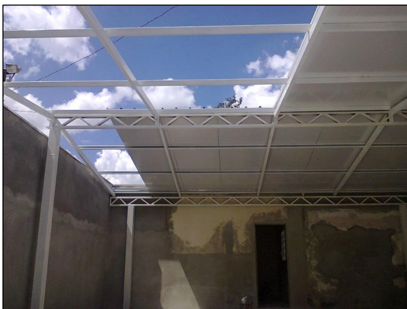
Figura 9 – Telha termoacústica com estrutura metálica.
