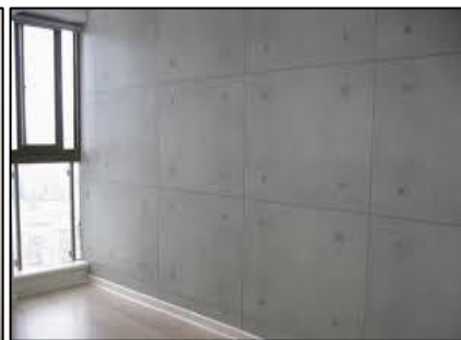
Figura 5 – acabamento placas cimentícias.
