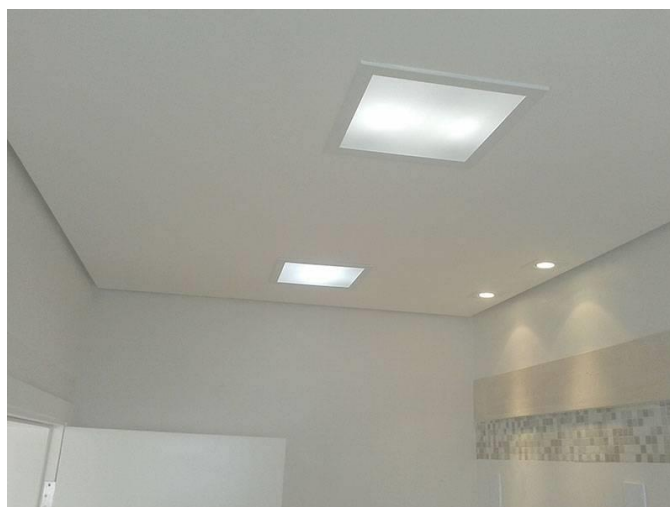
Figura 10 - Forro de gesso.
