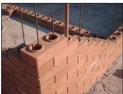
Figura 1 – Parede em tijolos ecológicos.
