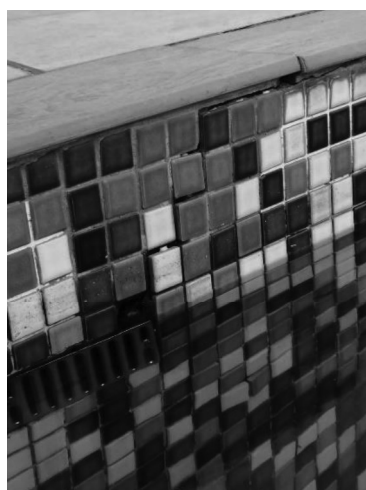
Figura 36 – Comprometimento do revestimento e rejunte na área do deck molhado por falta de manutenção adequada.
